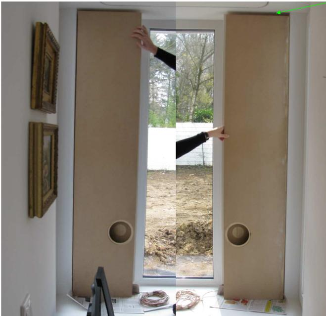
Für alle 5 Kanäle wurden gleiche 2-Wege Koaxiallautsprecher verwendet, die für die Einbaupositionen jeweils passend abgestimmte Gehäuse und Passivweichen bekamen.
